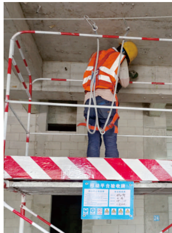
图3.1.2 安全带系挂水平生命线上效果图
