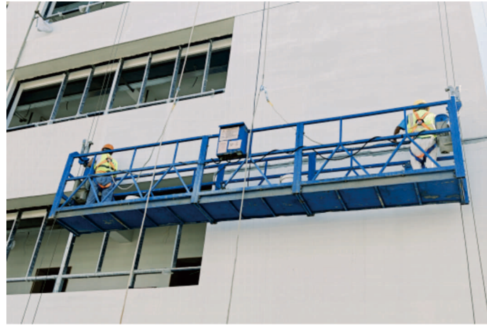
图3.1.12 高处作业吊篮作业人员安全带系挂效果图1
