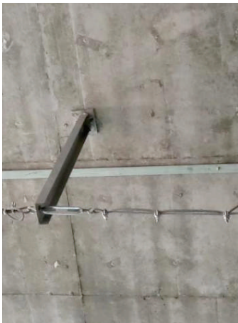
图3.1.3 水平生命线端部固定细节图
