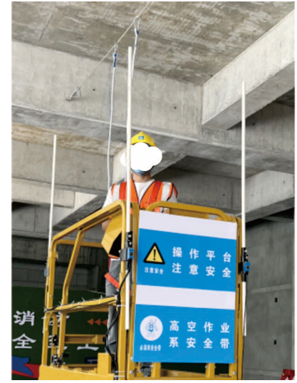
图3.1.10 剪叉式登高车作业人员安全带系挂在外挂点上
