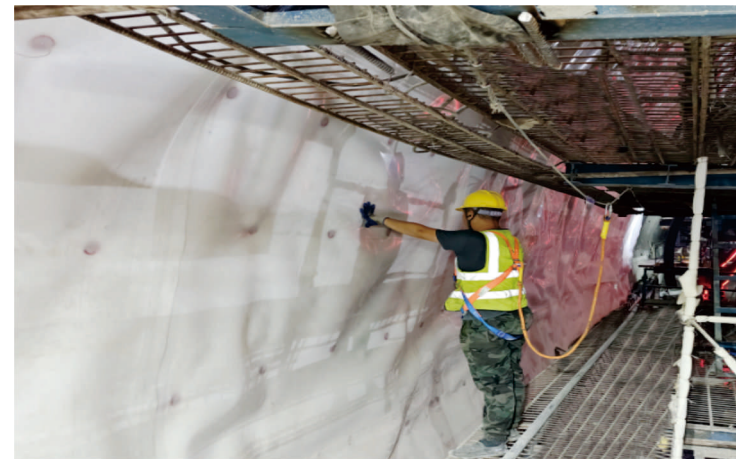
图3.1.6 隧道台车水平生命线设置效果图
