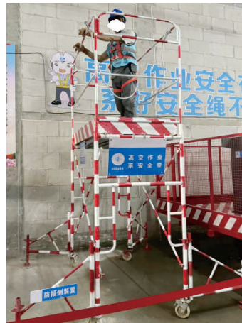
图3.1.1 安全带直接系挂在平台上效果图
