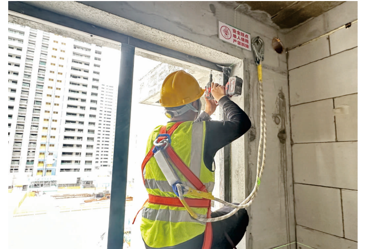
图3.6.3 利用挂点系挂安全带效果图
