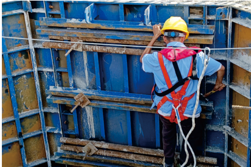
图3.3.8 墩柱模板作业安全带系挂效果图
