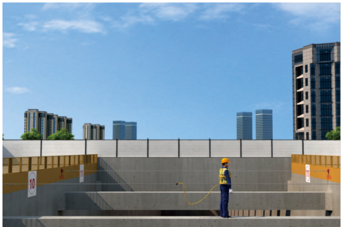
图3.4.4 利用挡水墙设置水平生命线效果图
