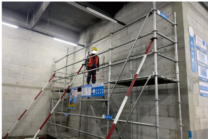
图3.5.1 利用连接盘设置作业脚手架水平生命线效果图
