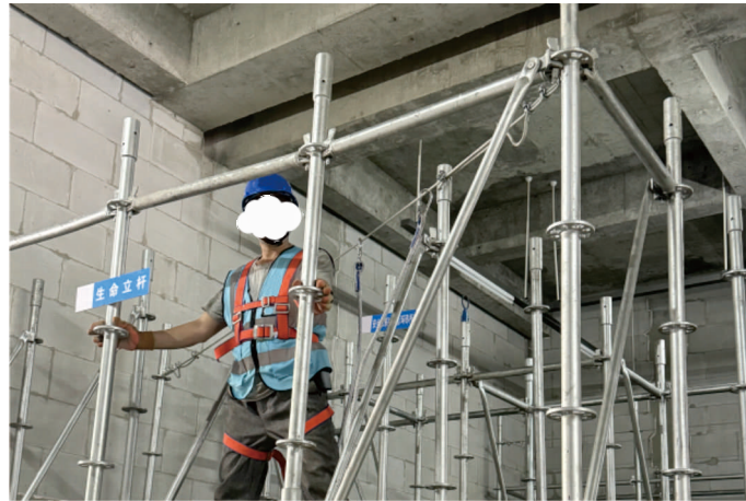
图3.5.2 利用连接盘设置支撑脚手架水平生命线效果图
