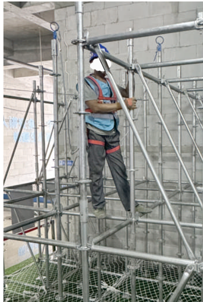
图3.5.4 利用环形插杆作为挂点效果图
