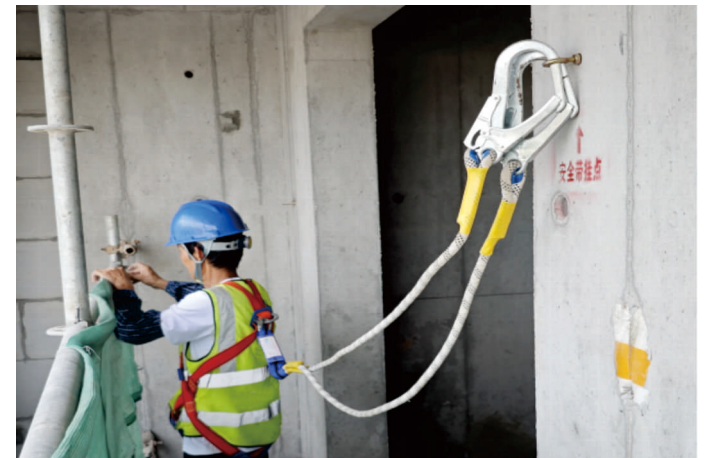
图3.6.2 利用挂点系挂安全带效果图
