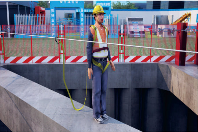
图3.4.2 安全带系挂效果图
