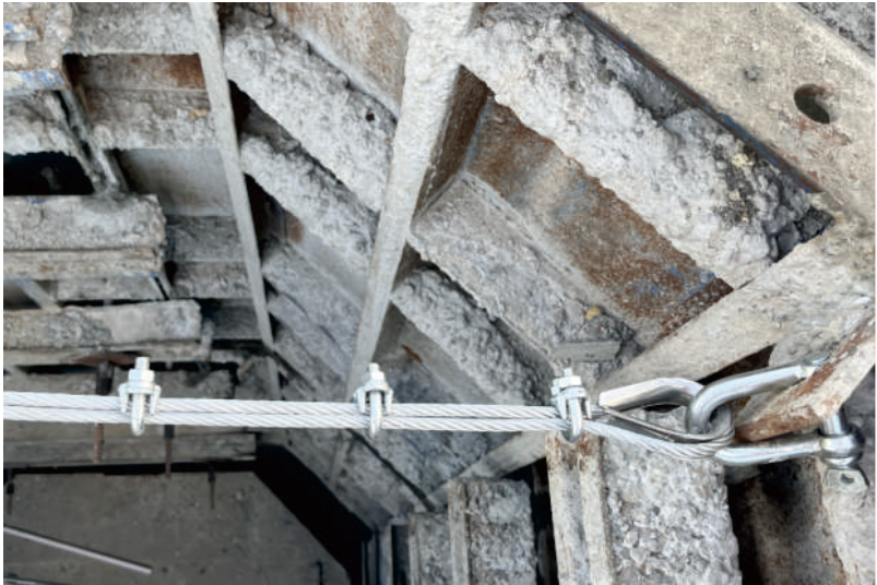
图3.3.9 墩柱模板作业水平生命线端部固定细节图
